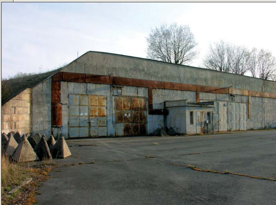
■ PRTB Kozlov – zodolněné úkryty pro skladování jaderných nosičů (současný stav)
