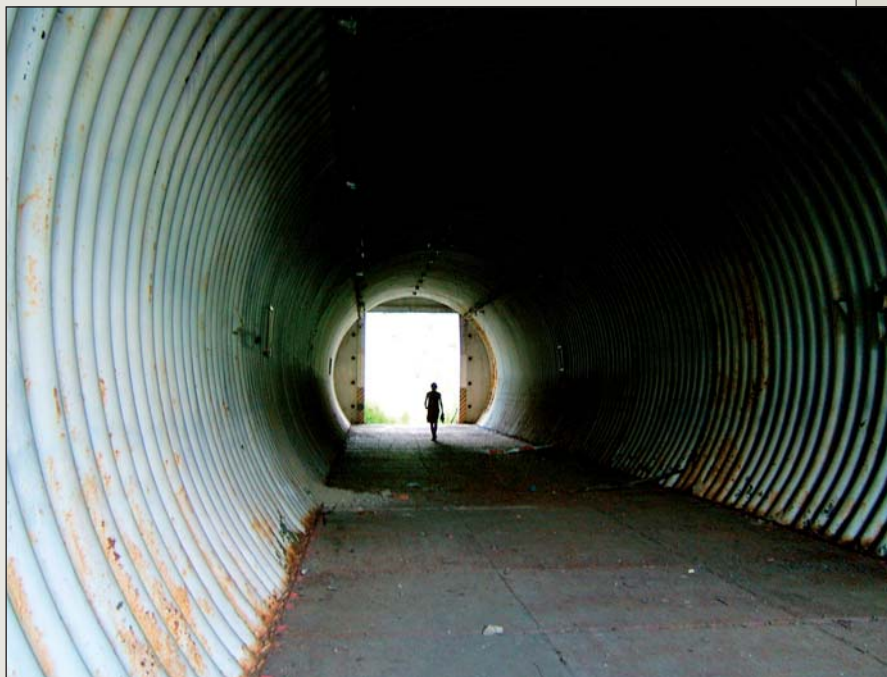
■ Palebné postavení „Sever“ – interiér průjezdního úkrytu sektoru B (stav z 7/2006)
